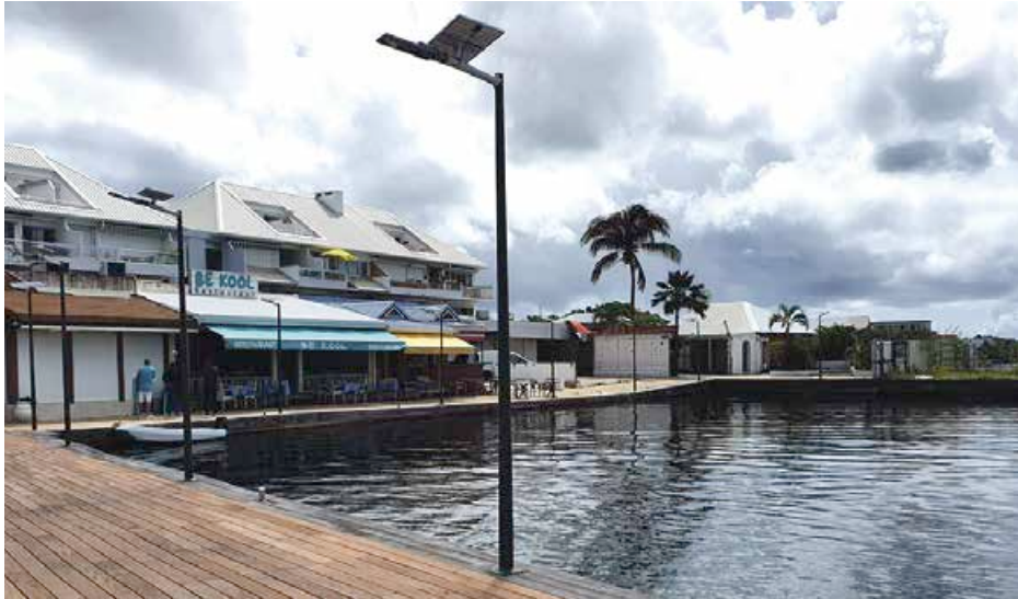
Les decks des pontons devenus dangereux ont été refaits en bois rouge. Une douzaine de candélabre à panneau solaire assurent désormais l'éclairage public sur le site.
