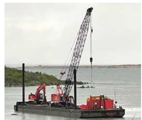
Depuis hier matin, une barge de la société Koole Constructor, mandataire du marché public, s'attèle à ramasser les quelque 2.35 tonnes de débris toujours présents au fond du lagon.
