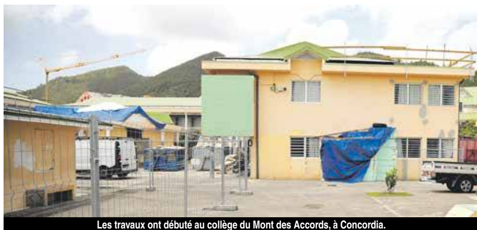
Les travaux ont débuté au collège du Mont des Accords, à Concordia.
