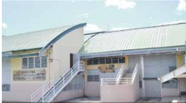
Au lycée Professionnel de Concordia, les ateliers techniques et leurs salles de cours sont réhabilités et seront prêts à accueillir les élèves à la rentrée scolaire.
