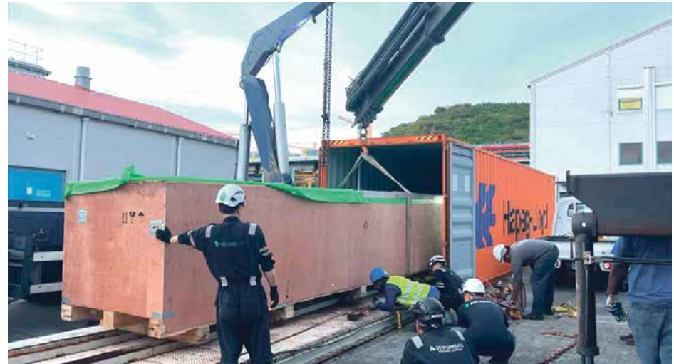
Déchargement de la pièce de 10 tonnes nécessaire à la réparation du premier moteur de la tranche 3.
