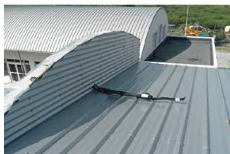
Les travaux d'étanchéité de la toiture sont achevés.
