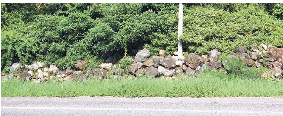
Muret de pierres sèches sur la route de Bellevue avant leur destruction
