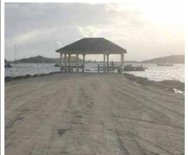
La Collectivité a réalisé des travaux d'ensablement et de confortement des berges dans la baie de Cul de Sac. Ces travaux ont eu pour but de dégrader l'accès au ponton de Pinel fréquemment utilisé par les bateaux passeurs qui assurent le transport de passagers vers l'îlet touristique. Le chantier a consisté à poser
